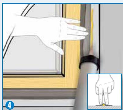
Benzile adezive ISOWINNOW F1,F11,F12 se aplică pe rama ferestrei după fixare acestei. Partea benzii cu pasă este tencuibile și trebuie aplicată vizibil spre exterior. Partea albă sau cea argintie de la ISOWINDOW F1 se lipeste pe peretele alăturat cu ajutorul sealantului AIRSTOP SPRINT sau AIRSTOP NP . La ISOWINDOW F11 sau F12 se folosește partea adezivă. Baza trebuie să fie curată, degresată și uscată.
