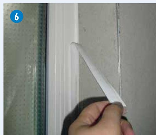
Etansati tranzitia intre T-FAL profil si banda cu 3Grip de etansare.
